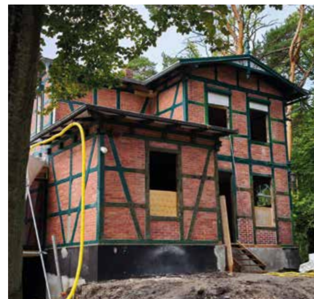
Ostseite der Villa Ruhleben, Sanierungsstand 14.9.2025.
