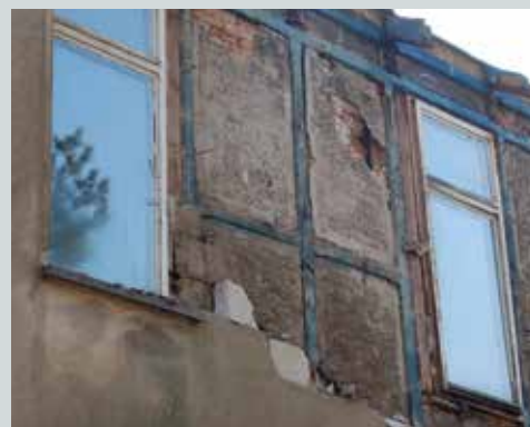
Die vorgesetzte Fassade.
