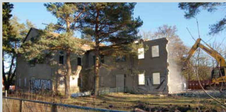
Abriss des Altenheimanbaus.
