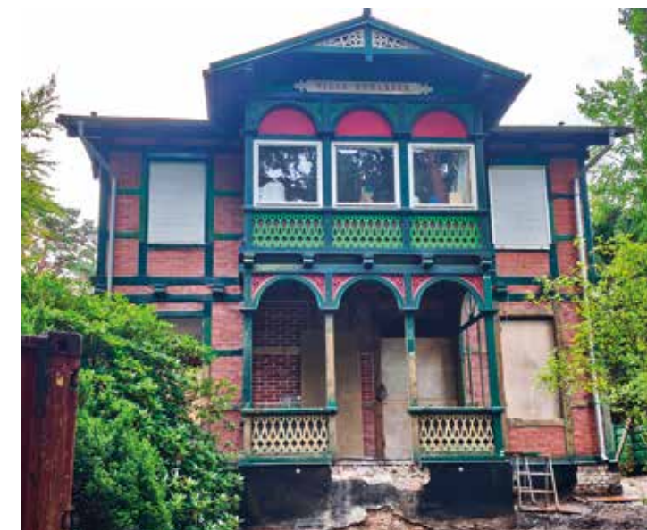
Nordseite der Villa Ruhleben, Sanierungsstand 14.9.2025.
