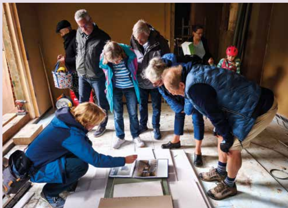
Während der Führung durch die Baustelle konnten die Besucher Fotos und Unterlagen zur Villa Ruhleben anschauen.
